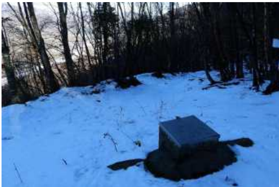
Figura 11: Presa d'acqua da sorgente per l'acquedotto di Carzago, ad Est dell'area di cava
